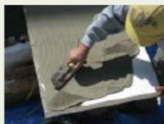
塗り付け後、クシゴテで長手方向にクシ引きをする。(クシ山の厚み7~10mm程度)(写真2)
