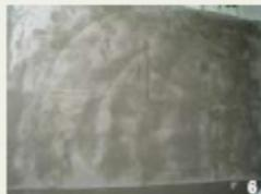
追っかけてFGネット(全面用/1×50m)を木ゴテか金ゴテで伏せ込んだ後、再度ECOアンダーIIを1~2mm程度塗り付け面調整をする。(写真6・7)
